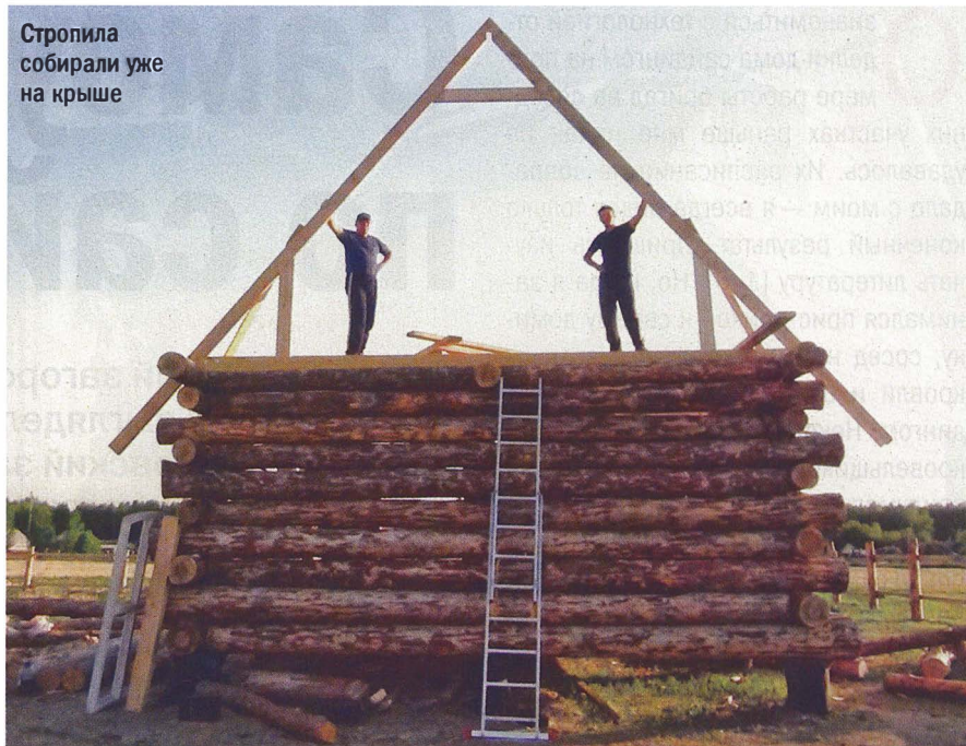
Балки перекрытий второго этажа
