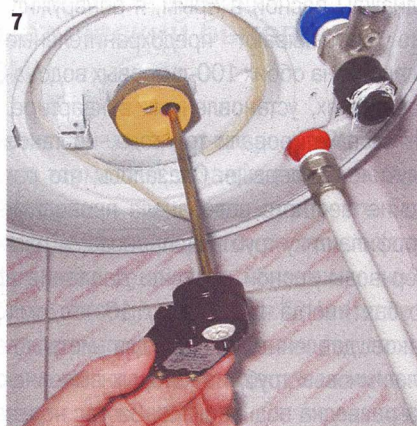
Аккуратно вынимаем терморегулятор. Датчик температуры представляет собой металлический стержень, который помещается в герметичную гильзу на блоке с ТЭНами.
