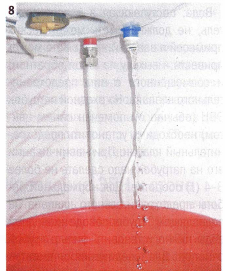
Сливаем воду из рабочего бака.
