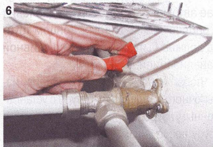
Полностью сливаем горячую воду из бойлера и перекрываем поступление воды в рабочий бак.
