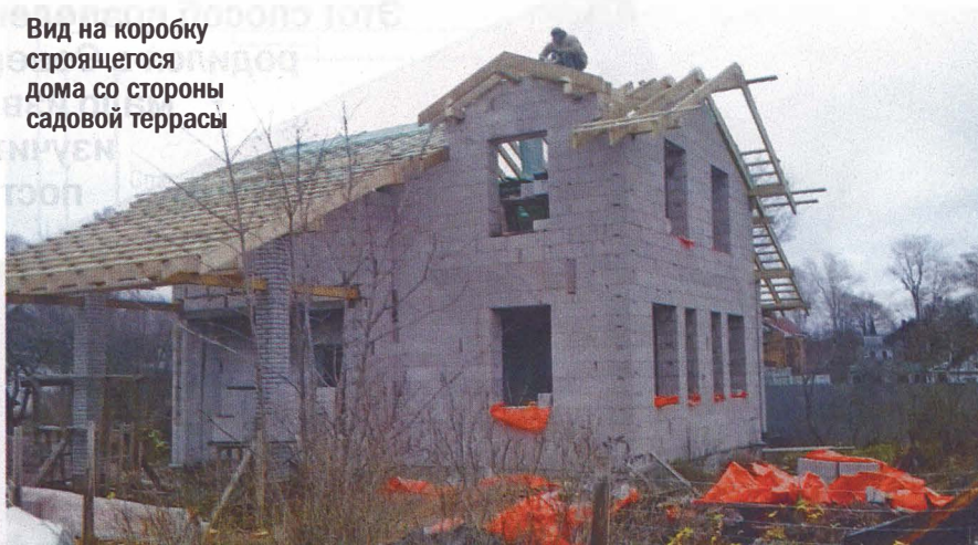
Вид на коробку строящегося дома со стороны главного входа
