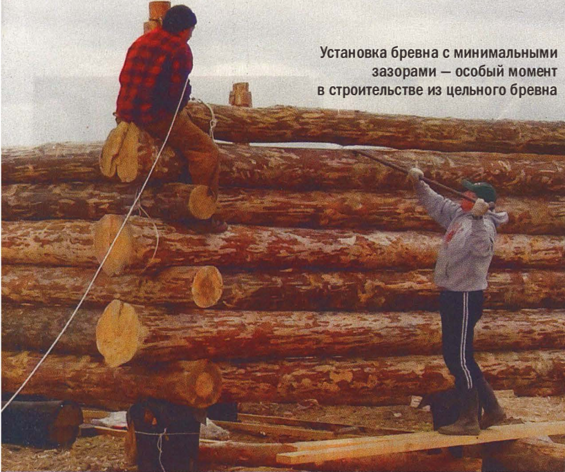
Рис. 2. Крепление брёвен в венцах коробки дома.
