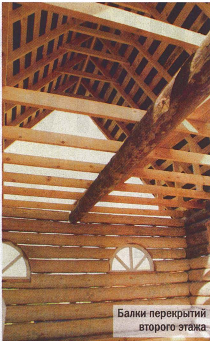
Стропила собирали уже на крыше
