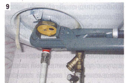
Гаечным или газовым ключом откручиваем гайку крепления блока ТЭНа с магниевым анодом.
